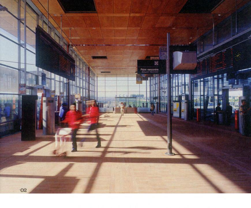
O1 Couverture de la toiture en bacs aluminium. Structure primaire en acier peint de teinte rouge. Au niveau du TGV, murs en béton sablé et panneaux acoustiques en CCV (Composite Ciment Verre). O2 Sol du hall incliné à 3%, en jatoba non traité, collé sur dalle chauffante. Plafonds en panneaux acoustiques habillés d'okoumé vernis mat. Photos: 01–02: S. Lucas. © SNCF AP-AREP.
