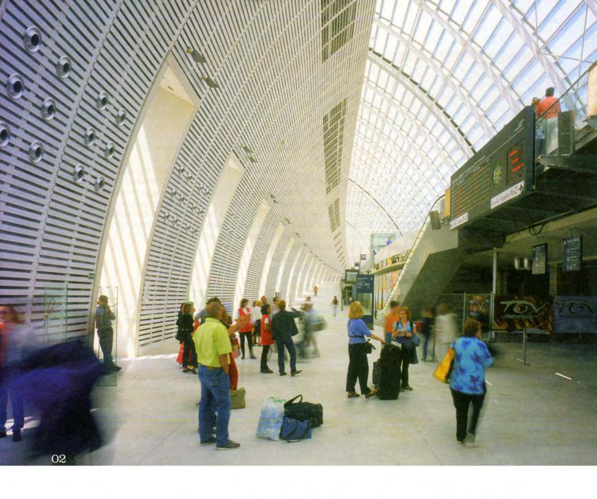
O1 Pavillon Départ: coque en composite ciment verre isolant. O2 Pavillon Départ: niveau inférieur avec les accès et services. Sol industriel coulé blanc.
